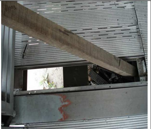
NO EXISTE LÁMINA EN EL PISO. SE OBSERVA HUECO
